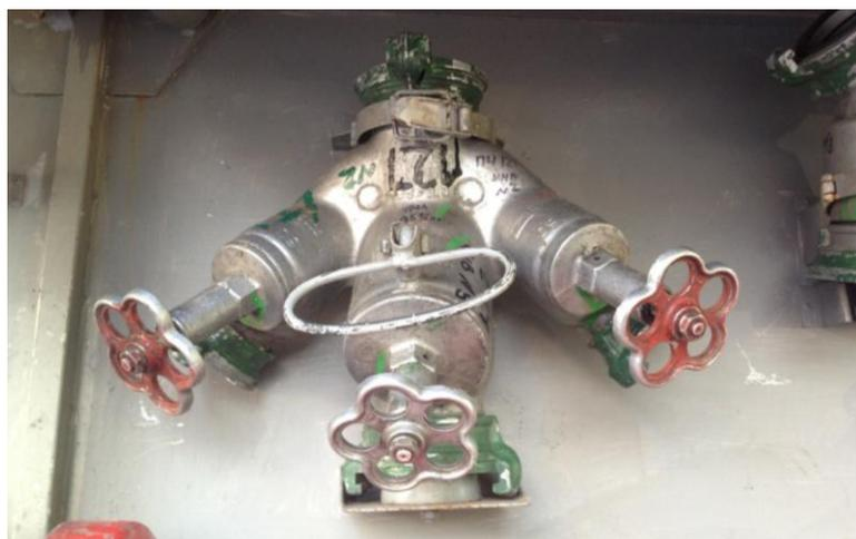
*Рис. 3. Крепление на стенке отсека металлическим хомутом*
